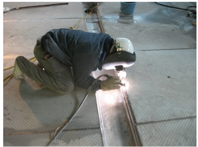
排水口の溶接
