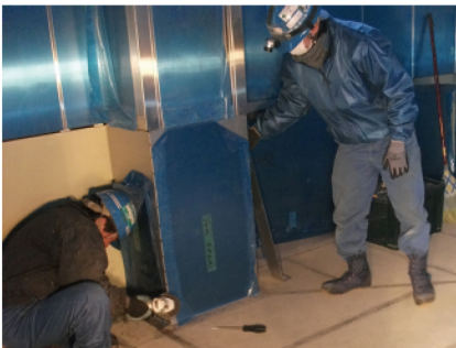
巾木との取り合いを溶接
